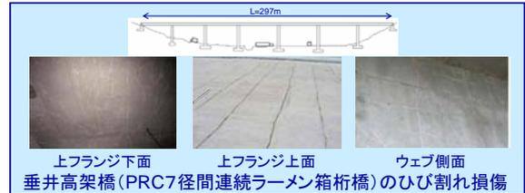
垂井高架橋 (PRC7径間連続ラーメン箱桁橋) のひび割れ損傷
